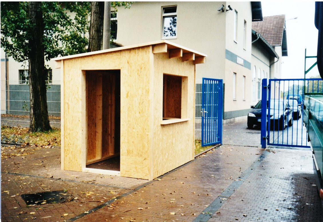
Das neue Häuschen, gebaut und gesponsort durch Volker Wäldchen
